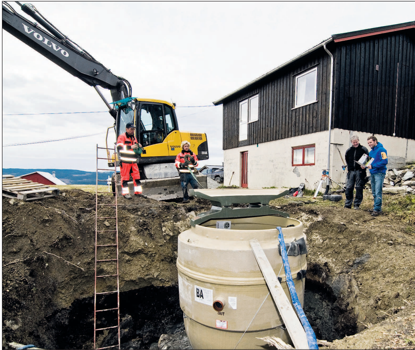
Ringebu kommune har nå godkjent mini-renseanlegget, og det første er montert på Fåvang. Åge Haverstad AS har utført entreprenørskapet, og prosjektselger Roy Magne Storholm kan sammen med kunde Jo Harald Bakken registrere at det hele blir som planlagt.
